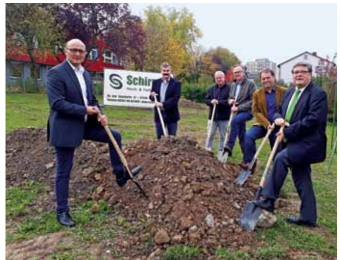
Spatenstich für die Neubaumaßnahme
