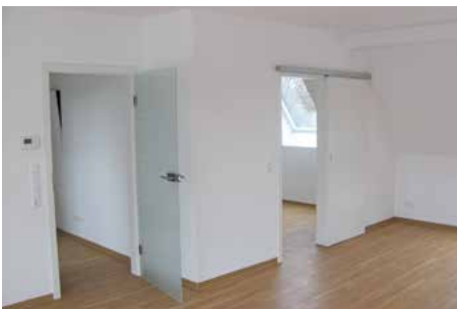
Wohnungen nach Modernisierung
