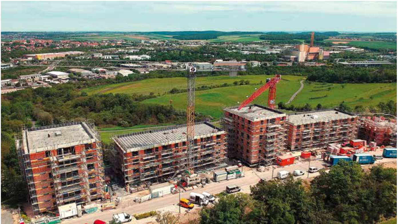
Ansicht Neubau Marie-Juchacz-Straße 3, 5
